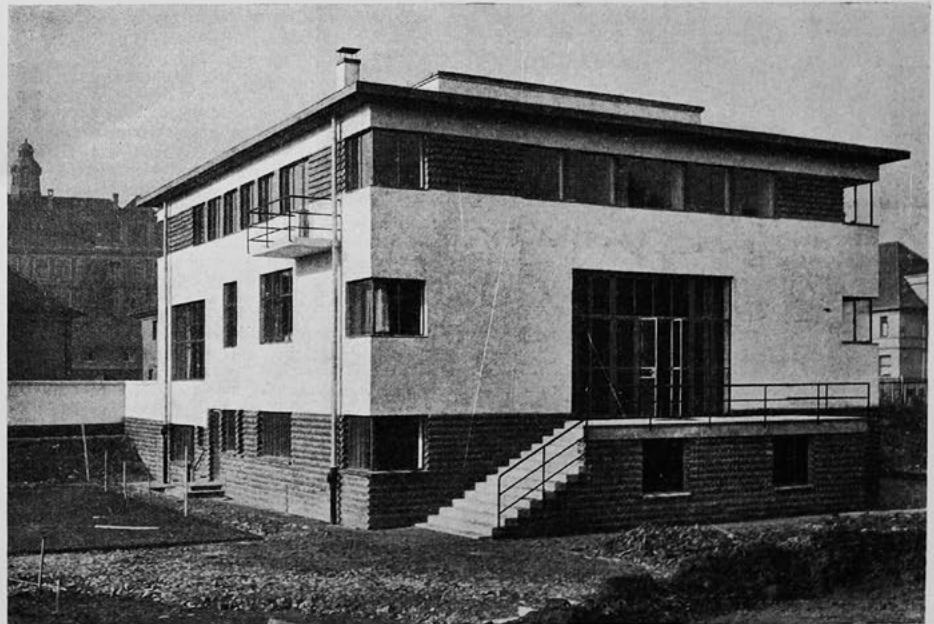
Abb. 8. Blick von Osten.
